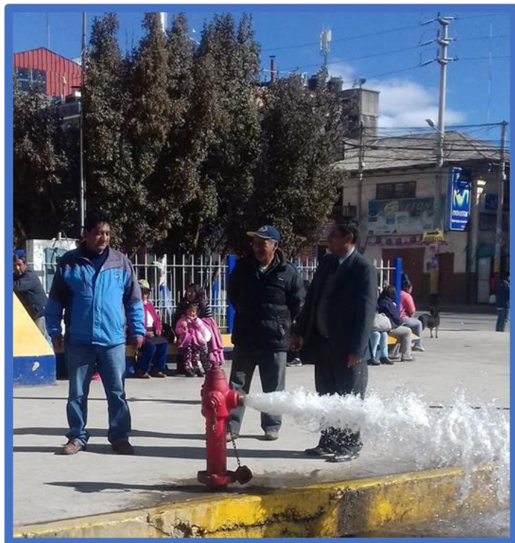
*Grifo contra incendio en la Localidad de Pasco – Distrito de Chaupimarca 0
