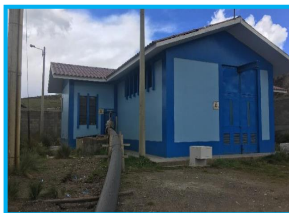
ESTACIÓN DE REBOMBEO GARGA
